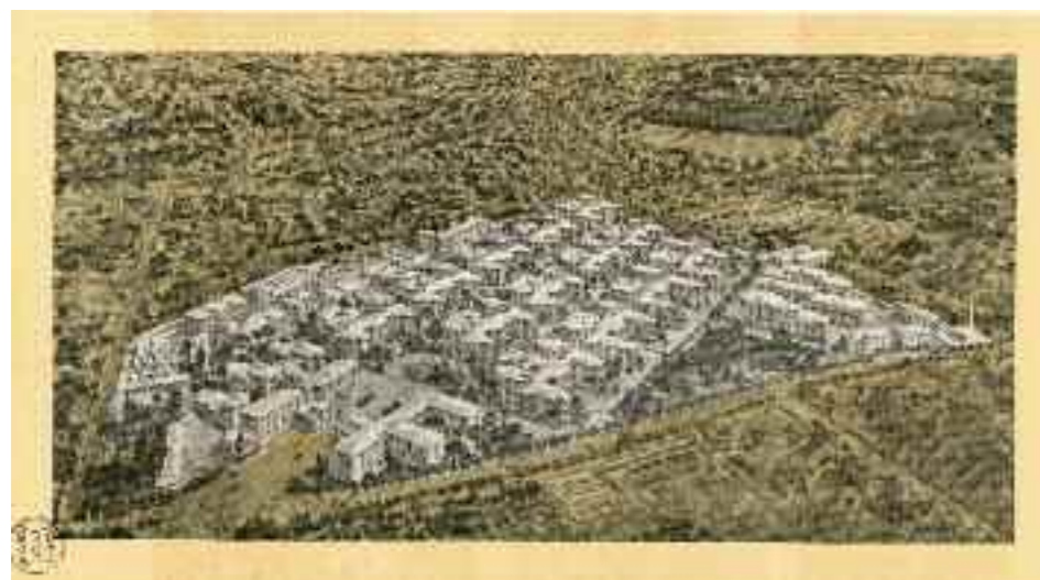
Vue aérienne de l'hôpital de Grange-Blanche - Étude sur les embellissements de la ville de Lyon et sur le développement économique de la région lyonnaise dans L'Architecture moderne, Paris, 1917, 28 p. Lyon, musées Gadagne, D 387
